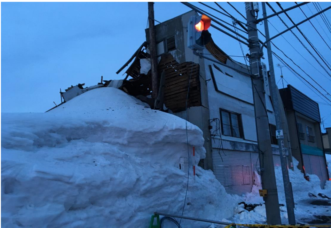
雪の重みで倒壊した家屋（北海道幌加内町）
