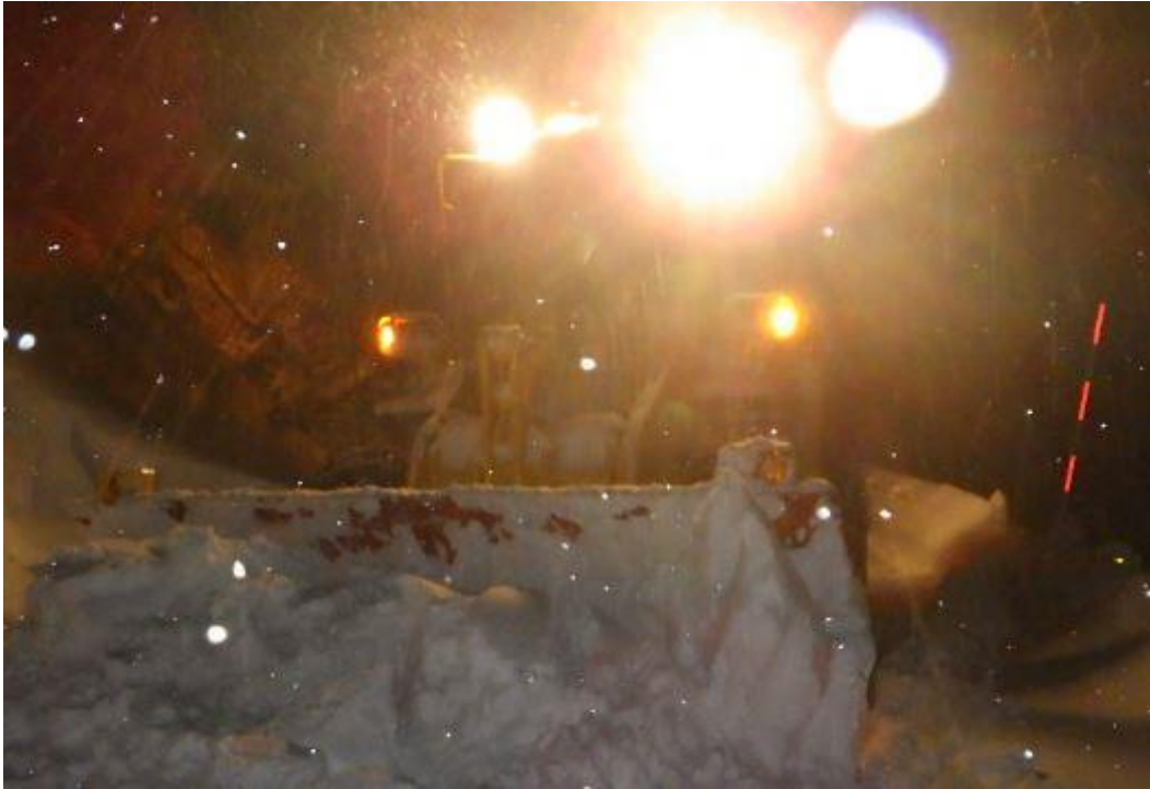
夜間も続く除雪作業（長野県栄村）
