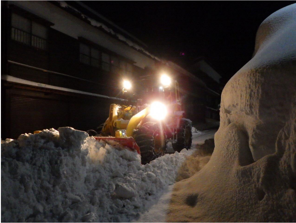
通行不能となった生活道路の除雪作業 (石川県白山市)
