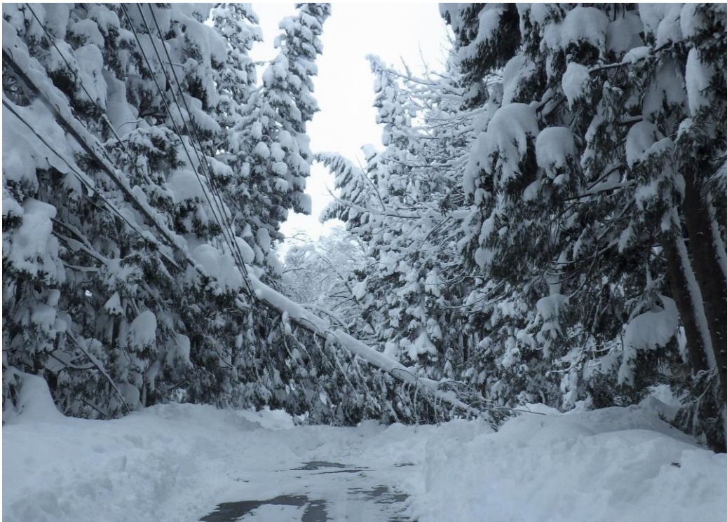
倒木による道路通行障害及び電力線との接触 (福島県金山町)
