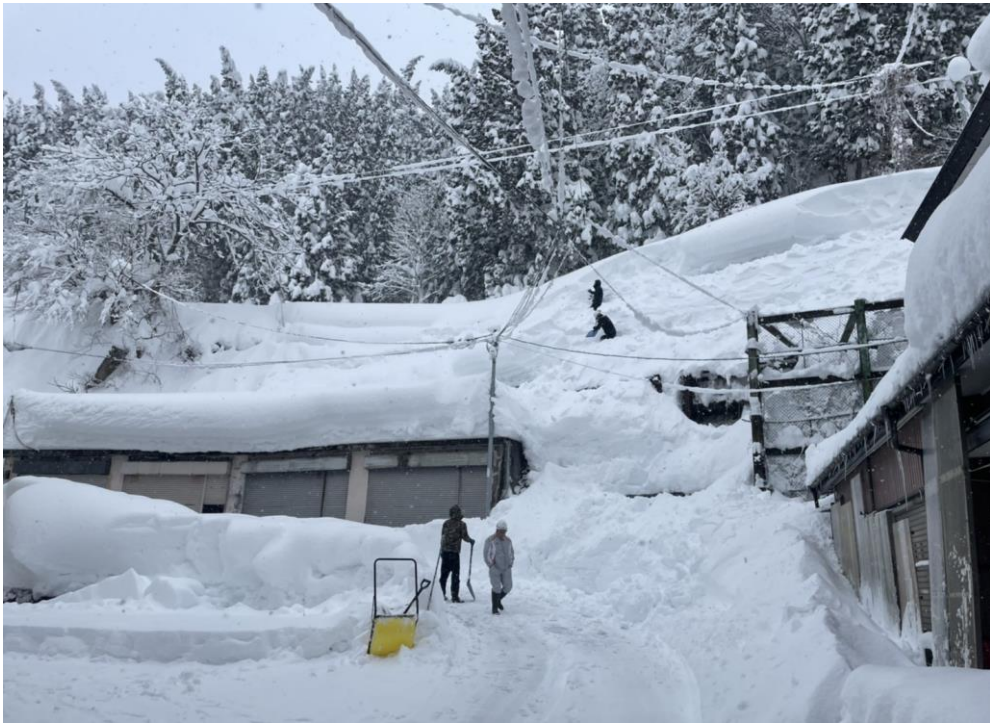
人力による道路雪庇除去作業 (山形県大蔵村)
