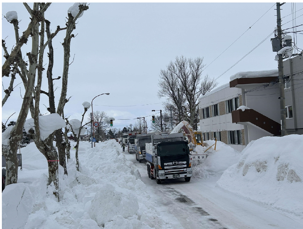
道路脇の雪壁の排雪作業 (北海道岩見沢市)
