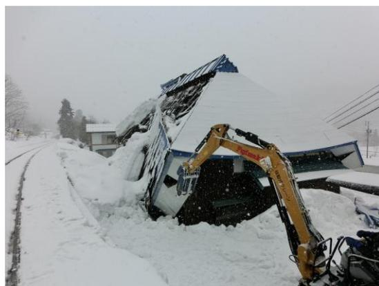
【写真6】雪により屋根が崩れ落ち、緊急安全措置により、危険部分の撤去 H25年2月
