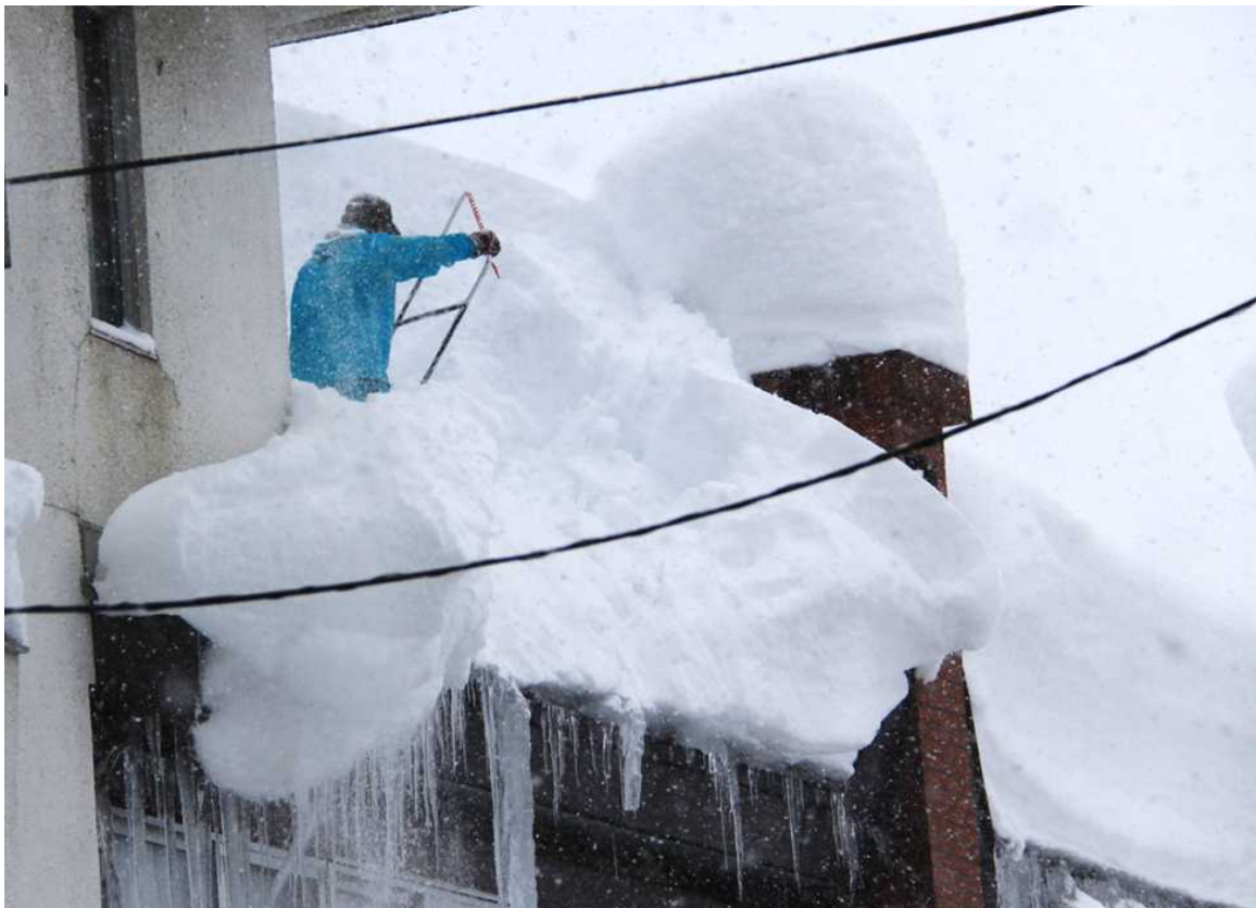
建物の雪下ろし（新潟県）
