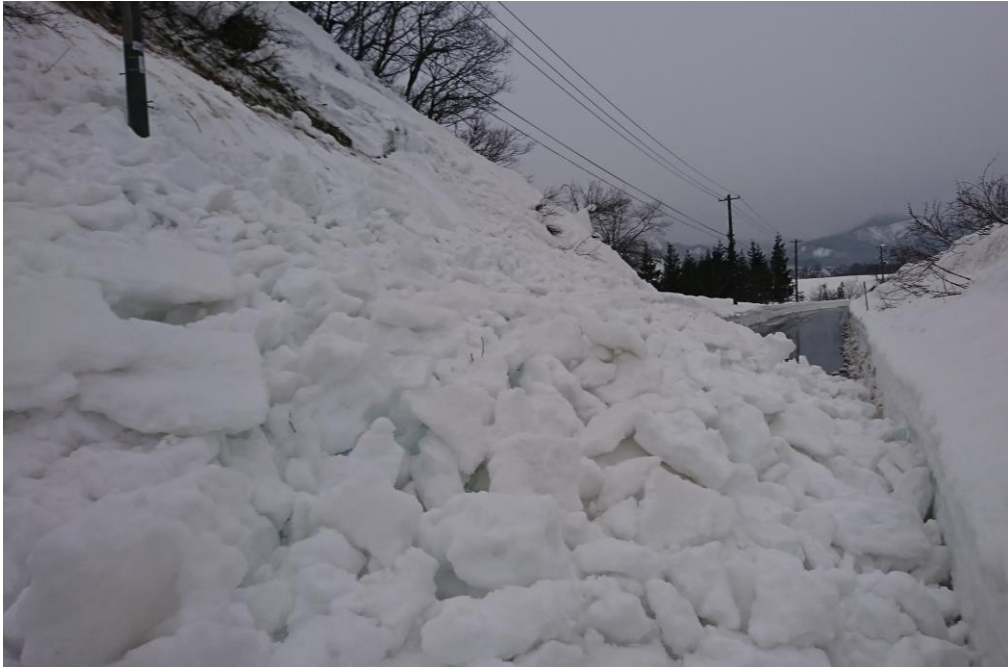
雪崩により通行不能となった道路（山形県舟形町）
