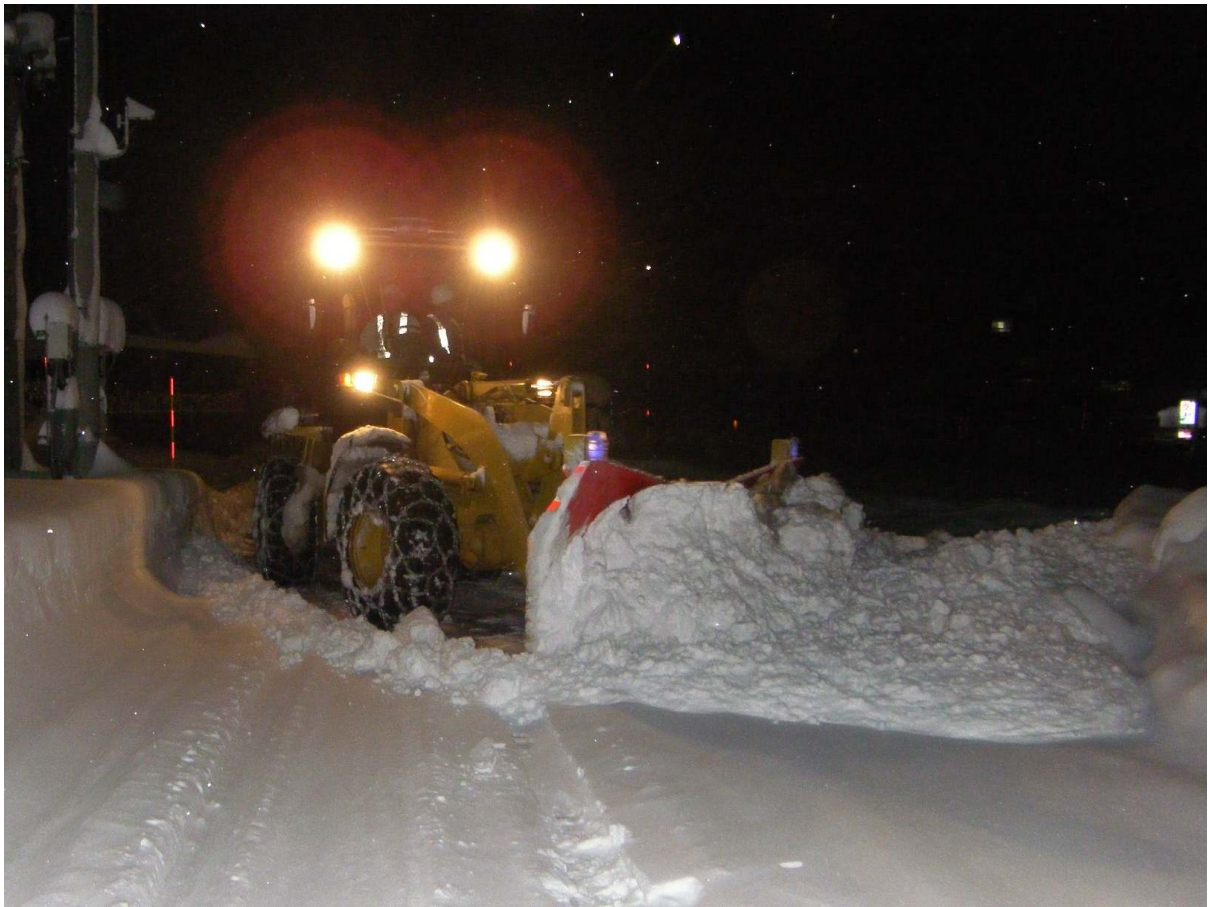
夜間も行われる道路除雪（新潟県湯沢町）
