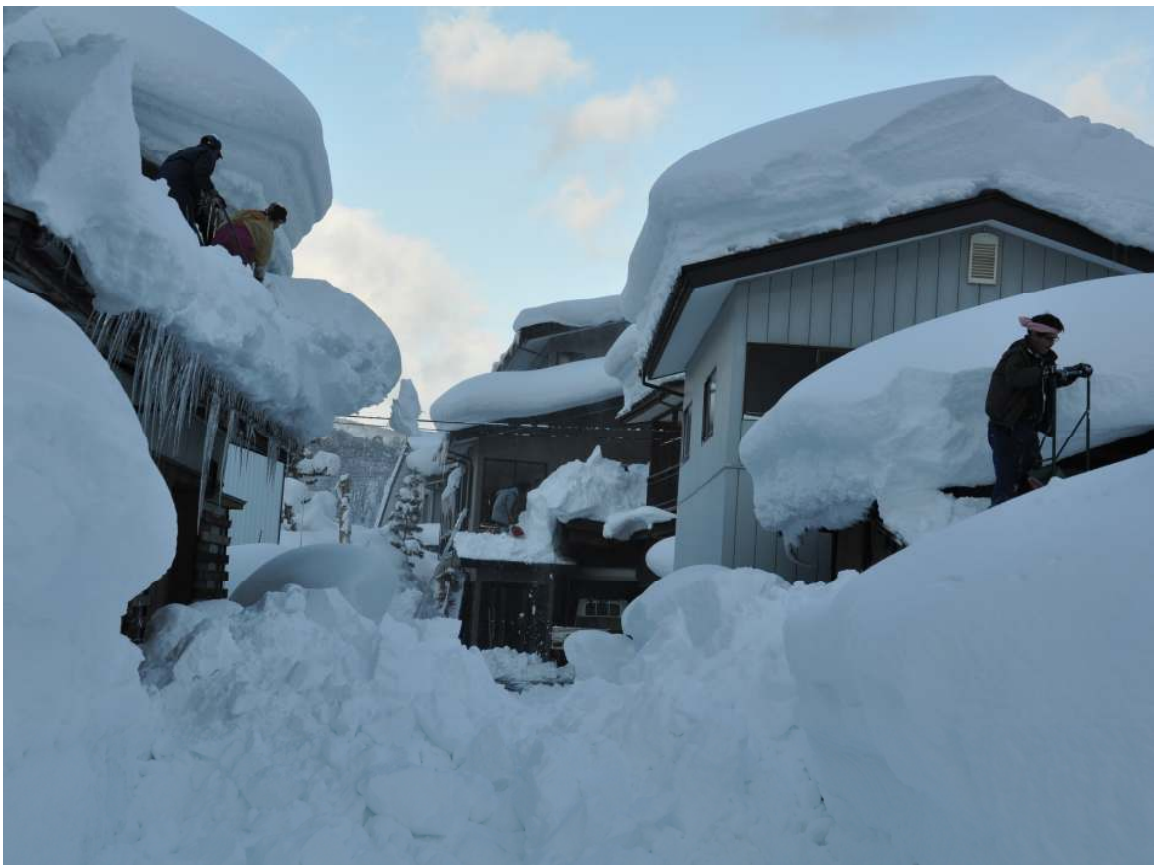
雪に埋もれた住宅（長野県飯山市）
