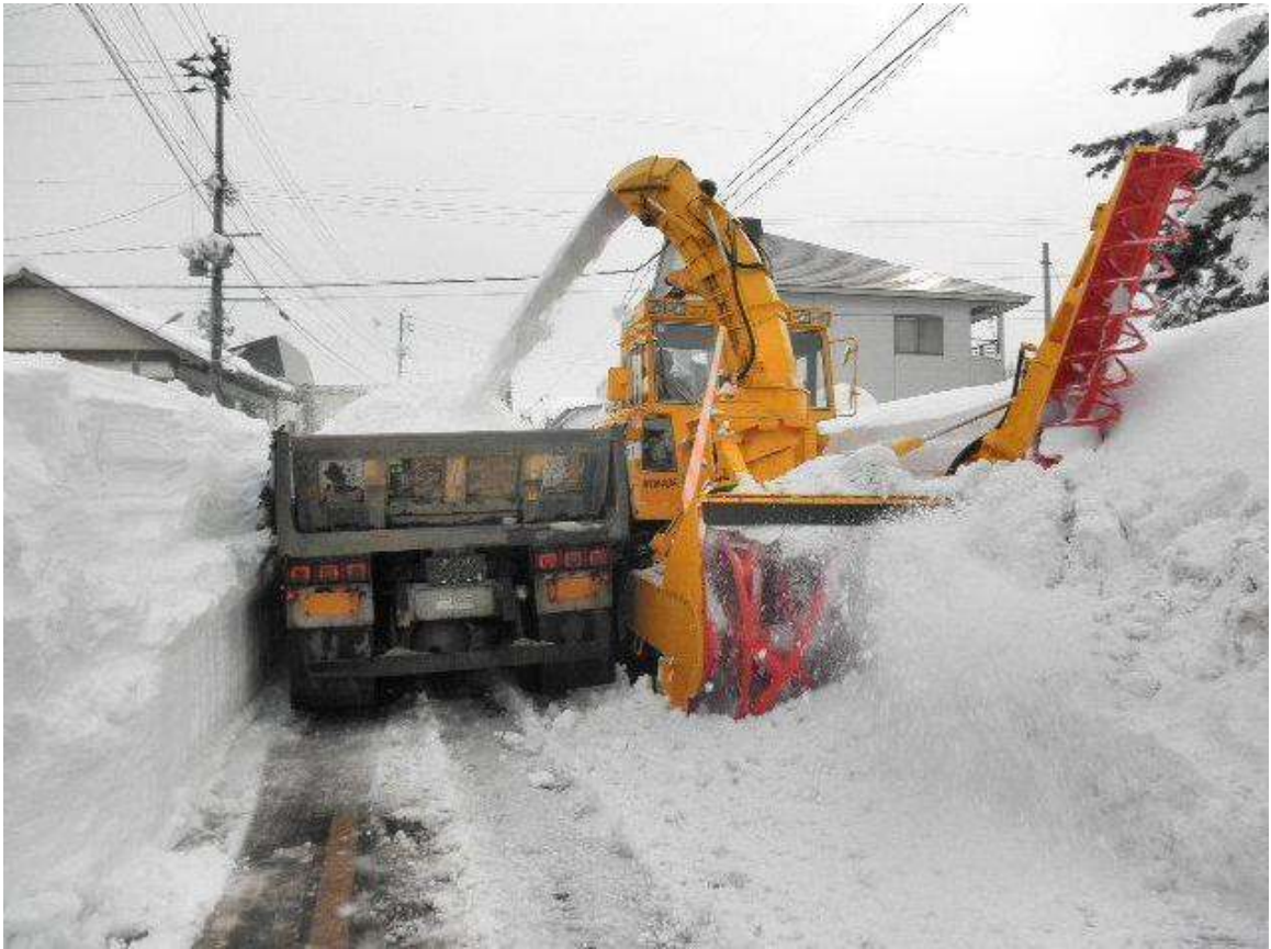
道路除雪（ダンプによる排雪）（新潟県上越市）
