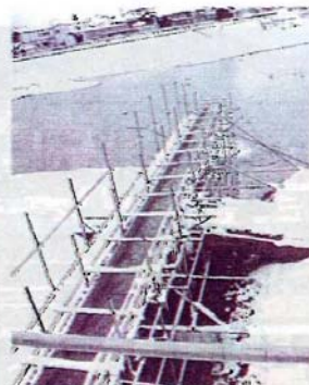
川の流心に流下させるために、流末先端に設置されたシュート
