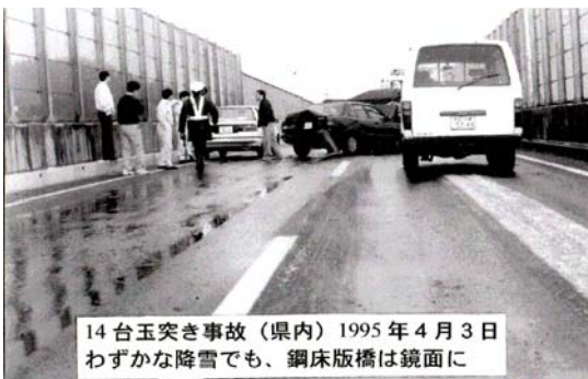
鋼床版橋のみが凍結しての事故
