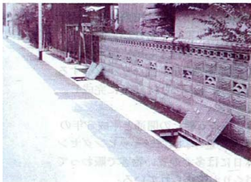
道路に施工された流雪溝
