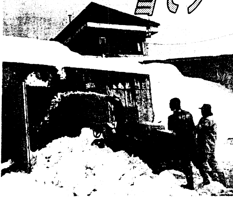
雪冷房システムの貯雪槽に雪を詰め込む作業＝山形県・舟形町で
