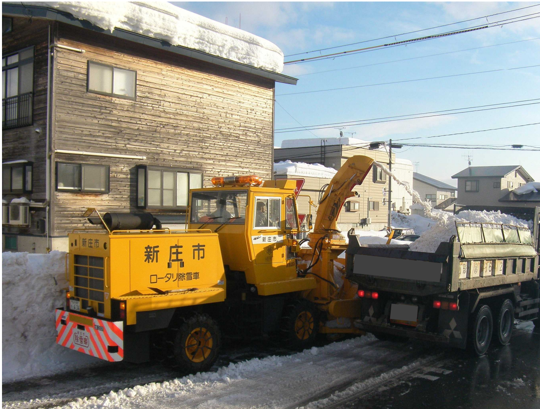
排雪の状況（山形県新庄市）
