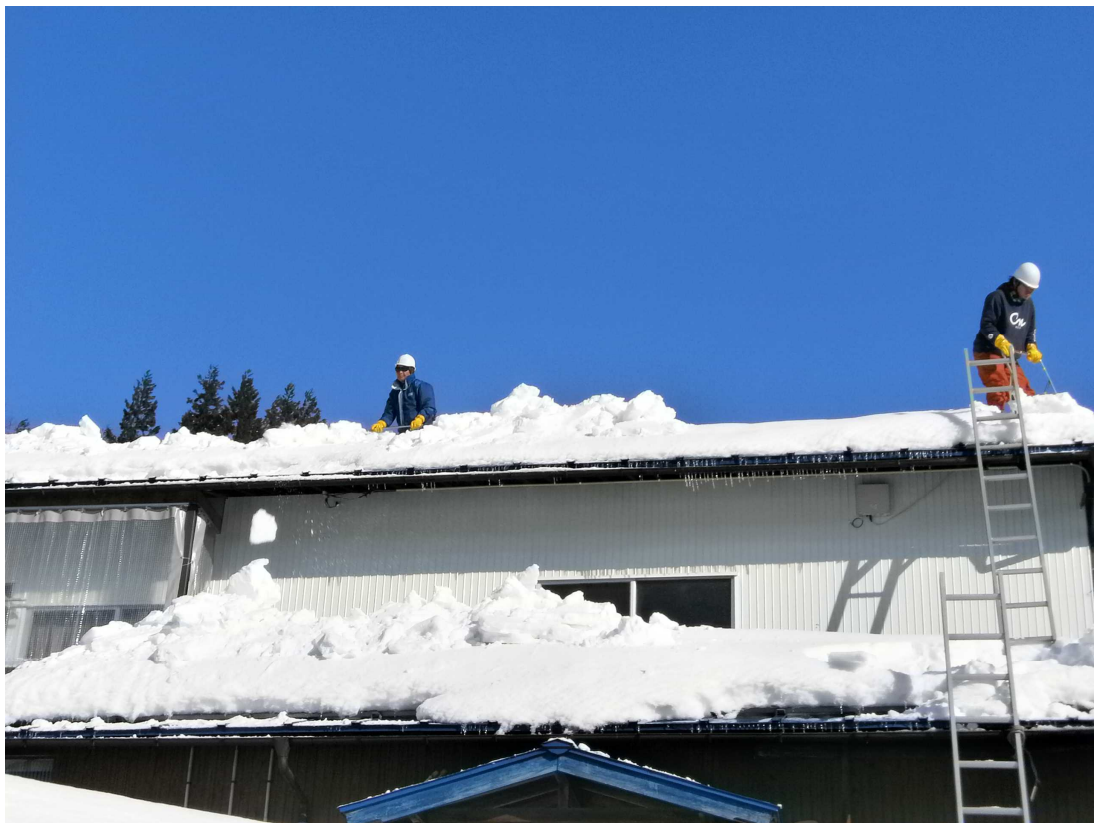
雪下ろしの状況（長野県栄村）
