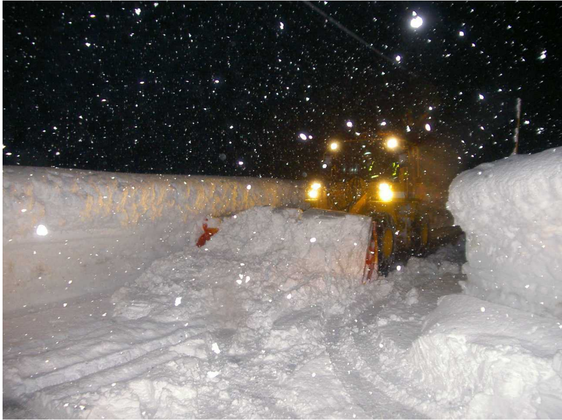
夜間も行われる道路除雪（新潟県魚沼市）
