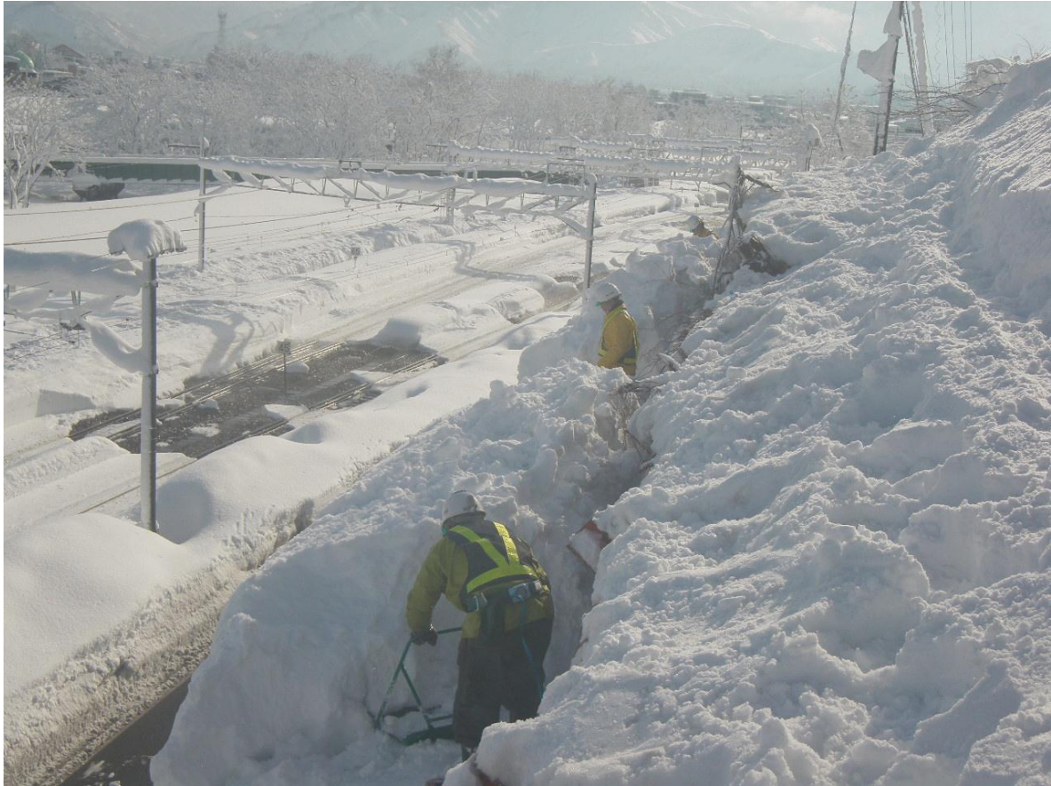
雪庇処理（新潟県魚沼市）
