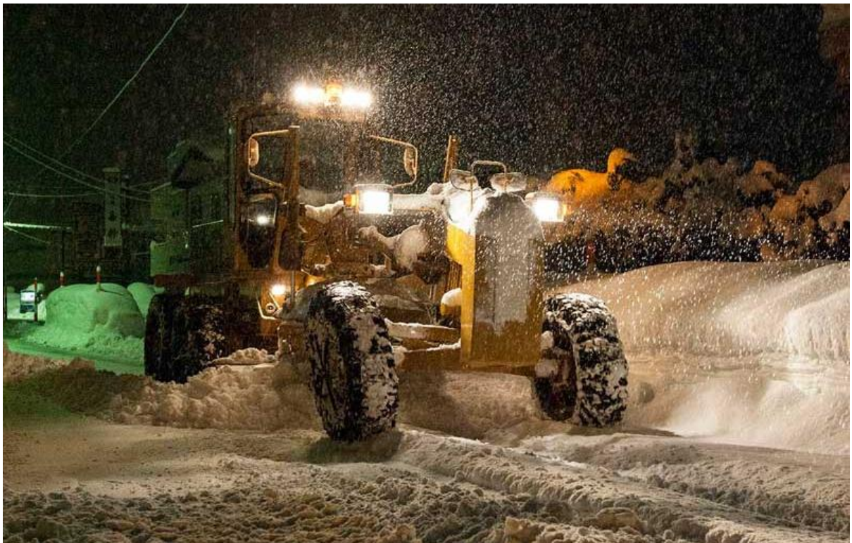
夜間も行われる道路除雪（秋田県）
