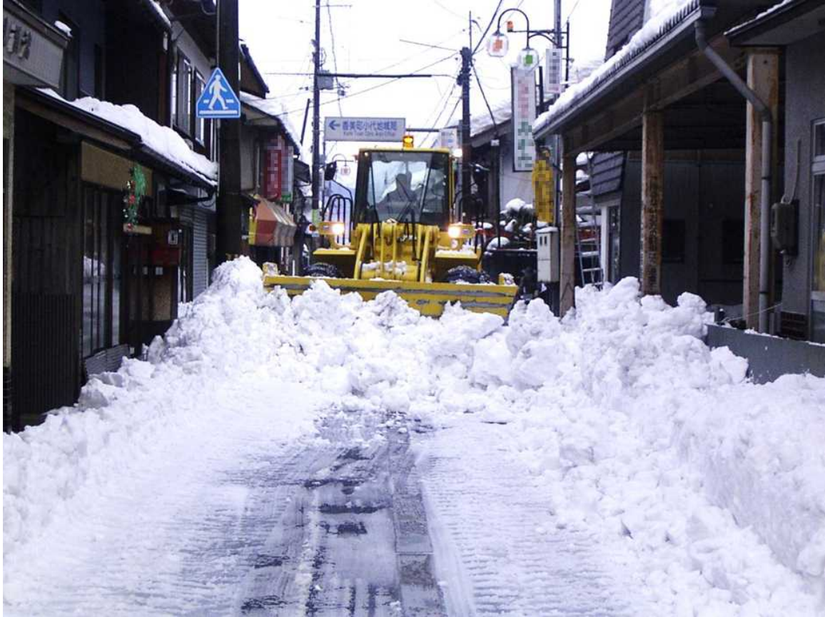
商店街の除雪作業（兵庫県）
