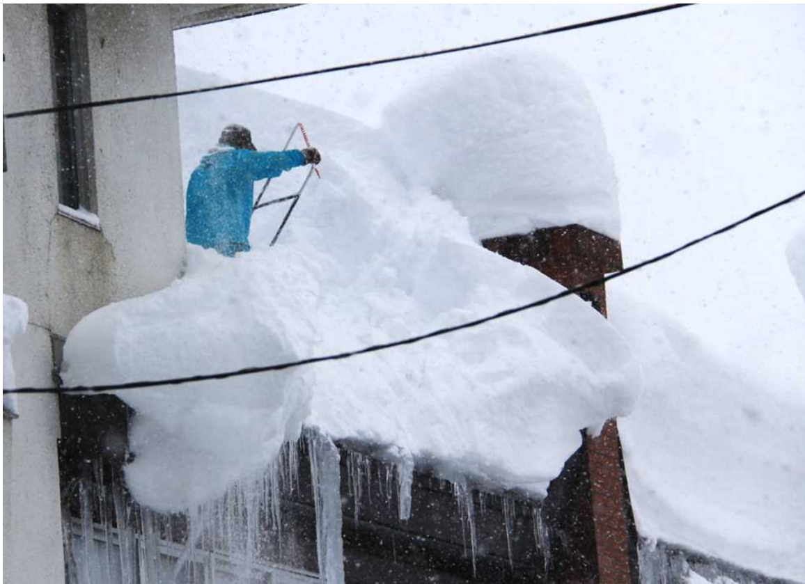
建物の雪下ろし（新潟県）
