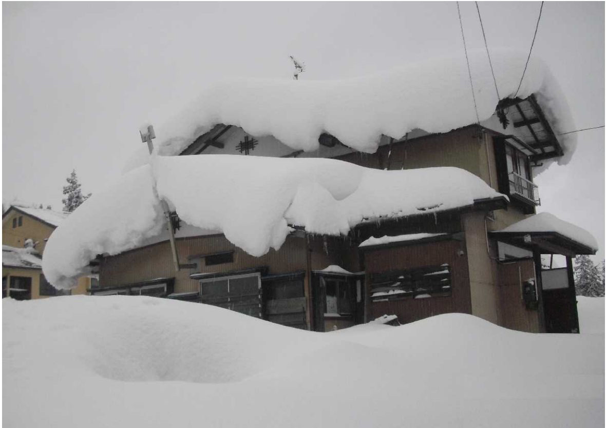
雪でつぶれそうな空き家（新潟県）
