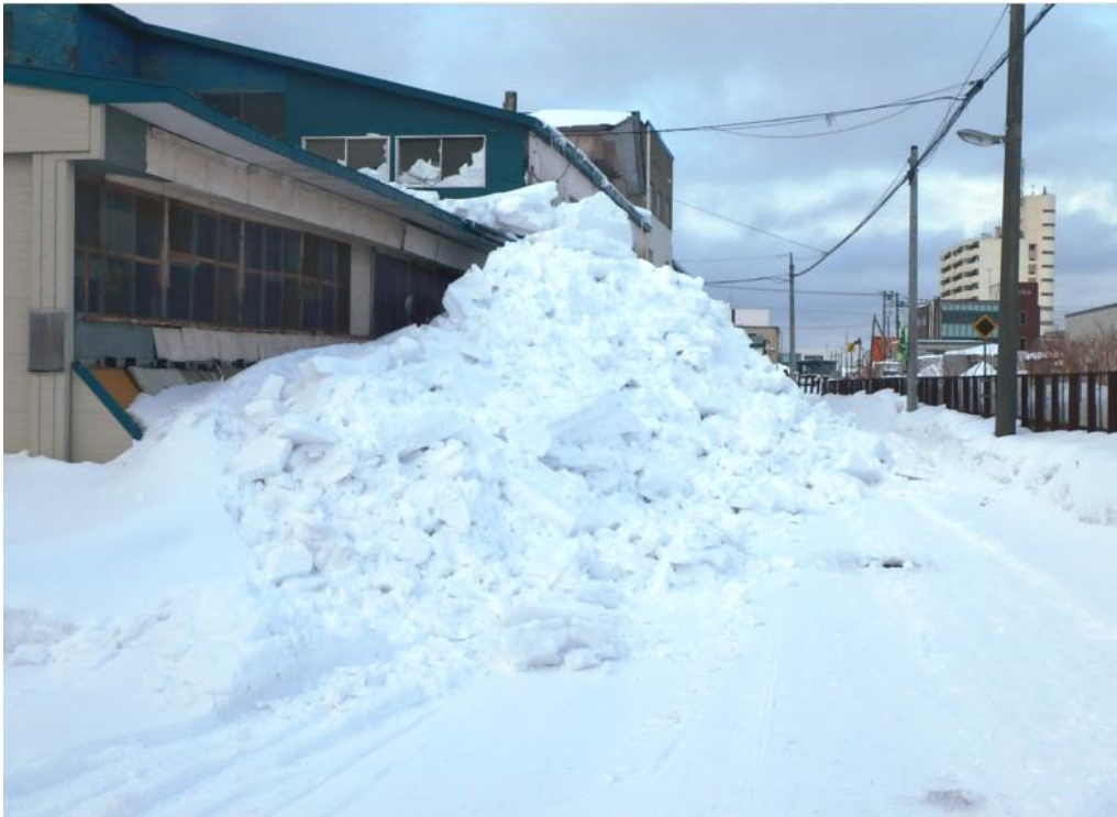
倉庫からの落雪が道路を塞ぐ（北海道稚内市）
