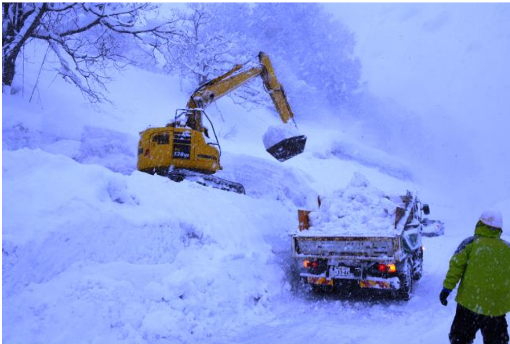
雪崩防止のため道路脇の雪庇を除去（山形県大蔵村）
